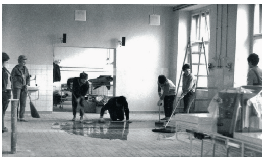
Obr. 4. Budování nového oddělení vlastními silami
