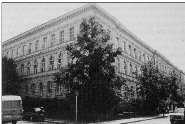
Obr. 3. Budova bývalého Nalezince
