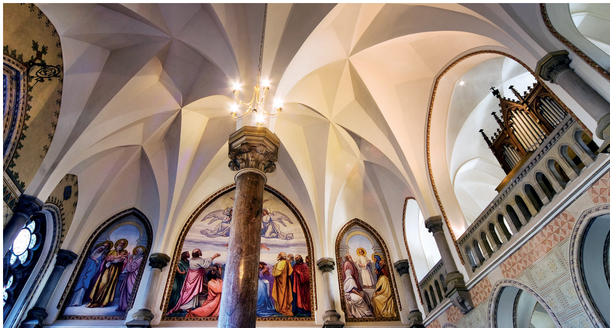
Obr. 4 Prostor kaple s hvězdicovou sklípkovou klenbou a malířskou výzdobou
