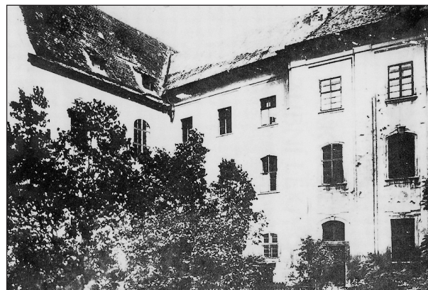
Obr. 2. Nádvoří olomoucké „všeobecné nemocnice“ s operačním sálem (2. patro)
